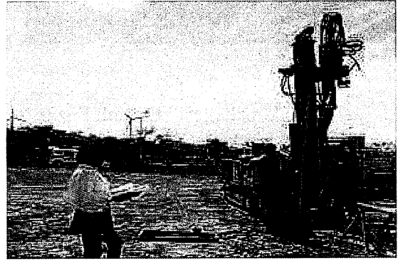
Çiftlik mahallesi “ Sosyal Tesis Projesi ” ne ait zemin ve temel etüt rapor Haziran 2023’te,
